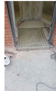
Pose, mise à niveau Fixation du cadre
